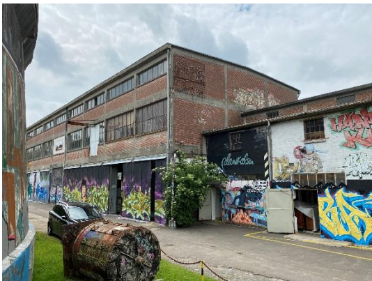
Ansicht Elektrowerkstatt (re) und Magazin (li)
