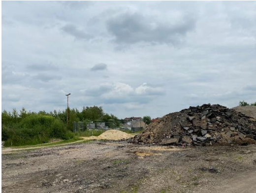
Abbruchmaterial auf dem Gelände
