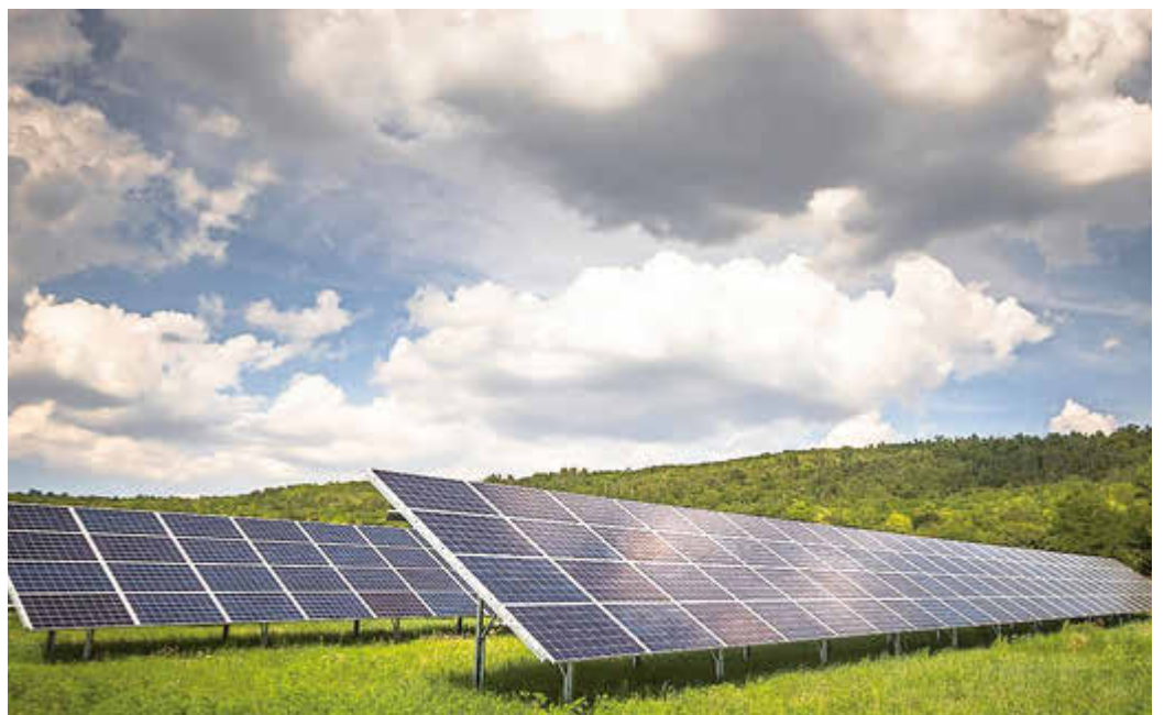
Photovoltaik-Anlage: Bis November will die Stadtplanungsabteilung einen Überblick über das Angebot an Freiflächen in Itzehoes Außenbereichen erstellen.
