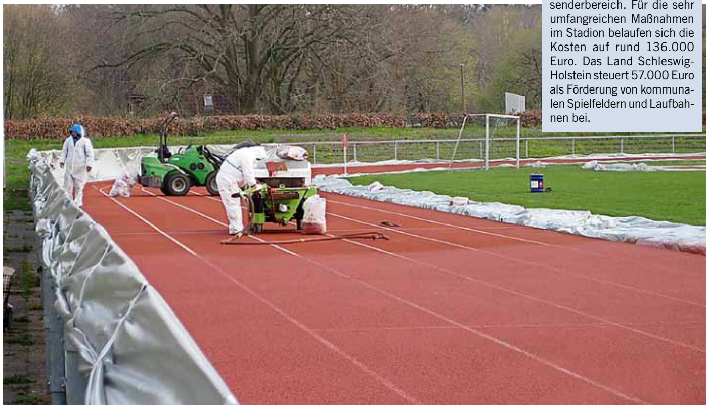
Neuer Belag: Fachkräfte bringen die Verschleißschicht auf.
