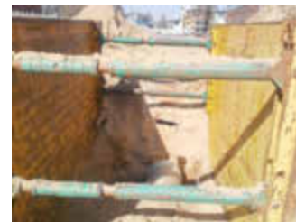
Freigelegt: Oberhalb des neuen Rohres ist der alte, gemauerte Regenwasserkanal zu erkennen.
