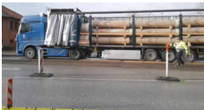
Anlieferung: Die Dimensionen der Rohrkolosse machen deutlich, warum für deren Verlegung ein Graben von etwa drei Metern Breite erforderlich ist.
