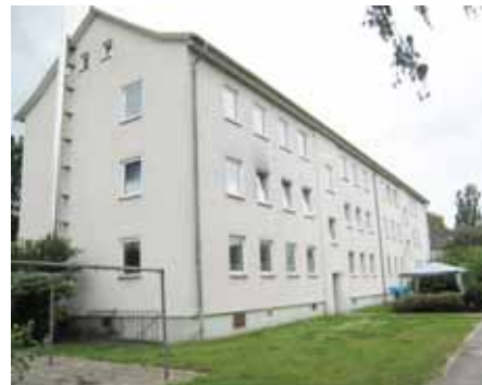
Wohnhaus in unmittelbarer Nachbarschaft des Abrisshauses am Luchsberg
