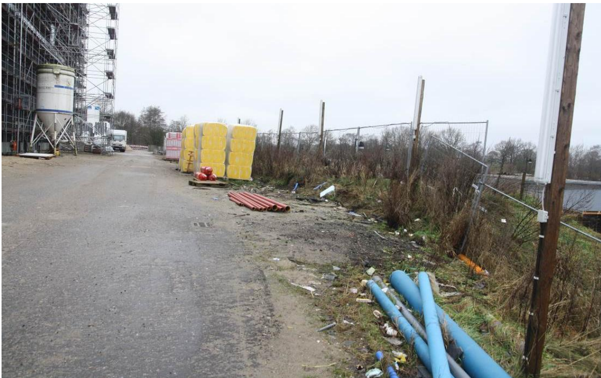
Abbildung 7-4: Nördliche Grenze des Grundstücks Fraunhoferstr. 1 mit Baustelle, links: neues Gebäude (03.01.2013).
