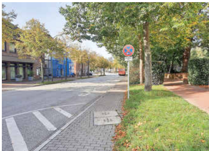
Viktoriastraße: Künftig wird es zusätzliche Pausenplätze für die Liniensbusse in der Wilhelm-Biel-Straße geben. Haltestellen am Theater sind weiterhin vorgesehen.
