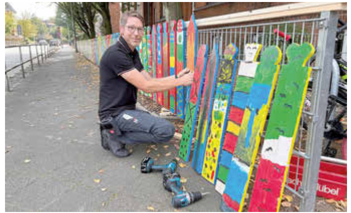
Angeschraubt: Andreas Albrecht montiert die letzten buntbemalten Latten an den grauen Doppeldrahtzaun.
