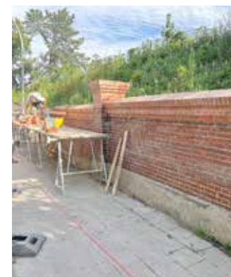
September: Die Mauer ist saniert – in Kürze sind auch die Absperren Geschichte.
