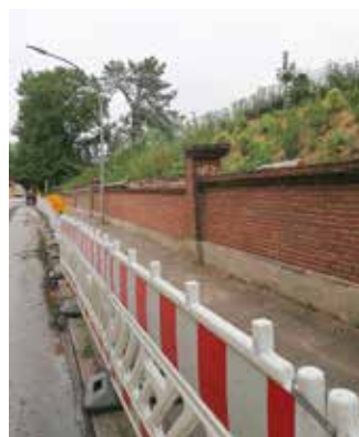
August: Der letzte Abschnitt der Stützmauer-Sanierung, die Maurerarbeiten, wurden in Angriff genommen.
