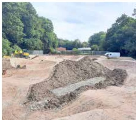
... zur Hügellandschaft. Rund 3.000 Tonnen Material wurden für die Modellierung der Strecke verbaut.
