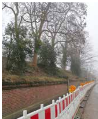
Februar: Die Bäume auf der Böschung mussten weichen.
