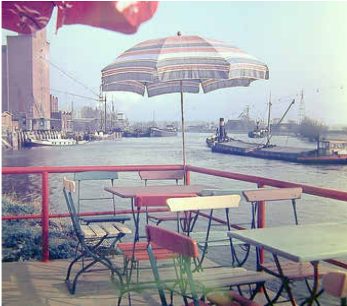
Damals: Von der Terrasse des „Störpavillons“ konnte man dem Schiffsverkehr zugucken. Foto: C. Brecht
