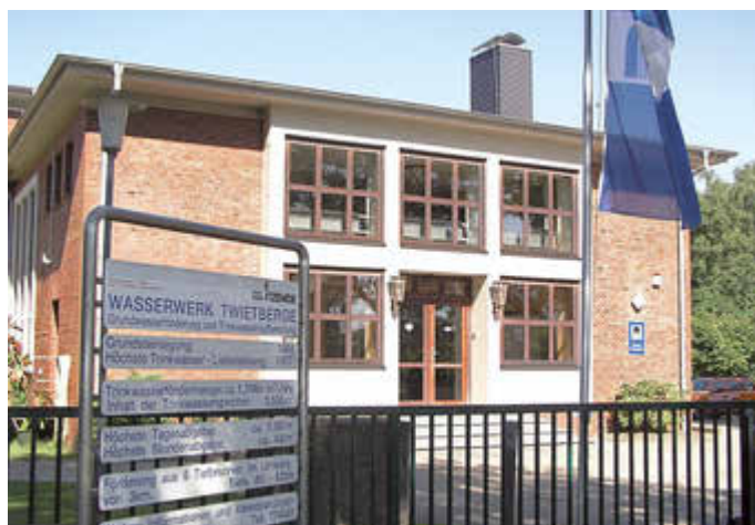
In die Jahre gekommen: Das Wasserwerk Twietberge muss durch einen Neubau ersetzt werden.
