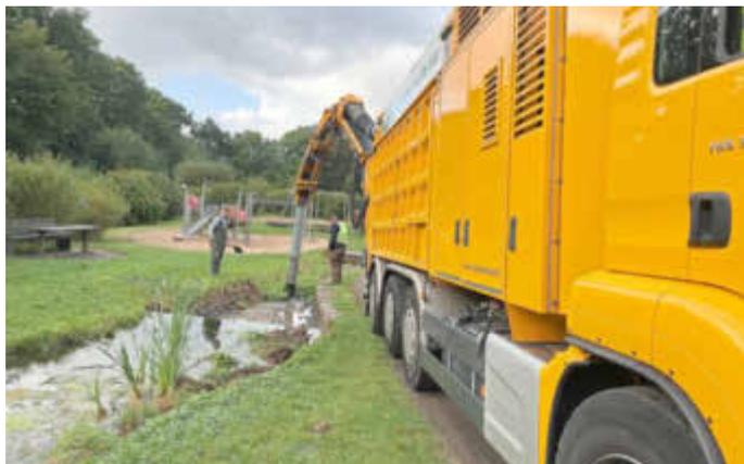
*Schweres Gerät: Der Schlamm-sauger befreit den Wasserlauf von Verkrautungen und Sand.*
