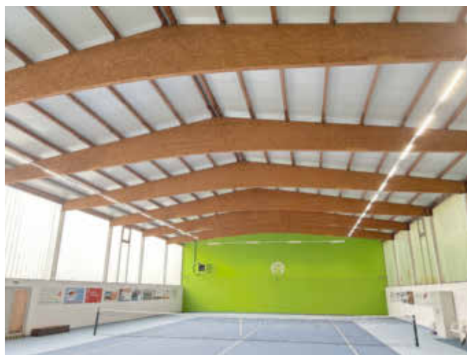
Nicht nur von außen Top: Das neue Hallendach ist jetzt wieder dicht und bestens isoliert.
