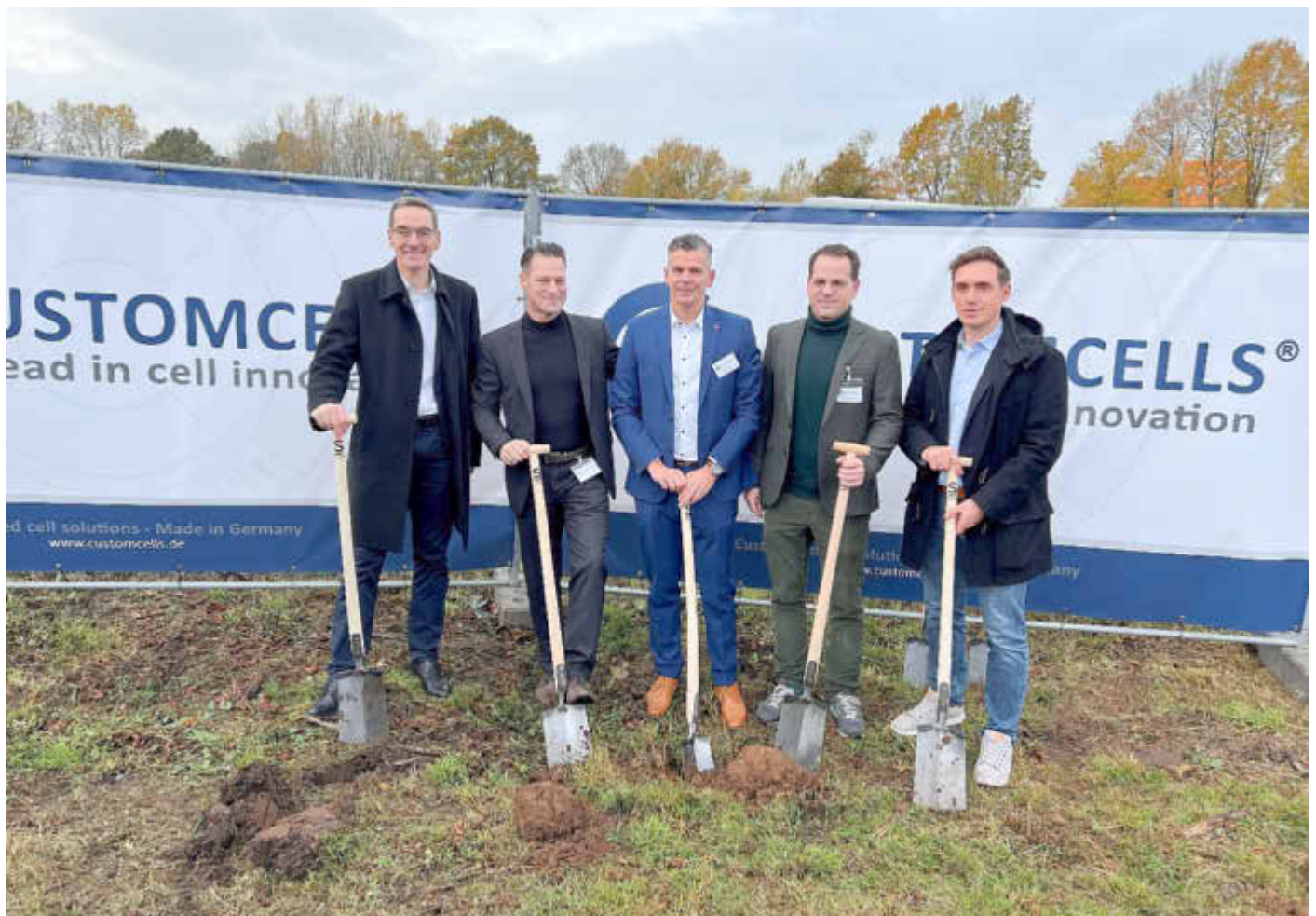
Spatenstich für das neue Bürogebäude: Bürgermeister Ralf Hoppe inmitten der CUSTOMCELLS-Chefs (v. l.) Martin Peters (operatives Geschäft), Dirk Abendroth (Vorsitzender Geschäftsführer), Co-Gründer Leopold König und Benno Leuthner (Geschäftsführer CUSTOMCELLS Itzehoe).
