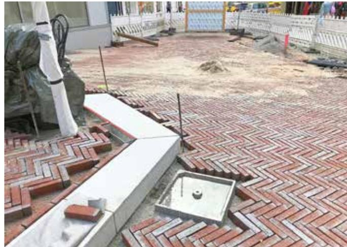
*Versorgung: Bei Bedarf wird der versenkbare Anschluss für Strom und Wasser hochgefahren.*
