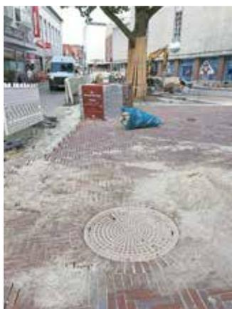
*Unscheinbares Detail: Unter der Schachtabdeckung verbirgt sich eine Bodenhülse inklusive Stromanschluss für einen Tannenbaum.*
