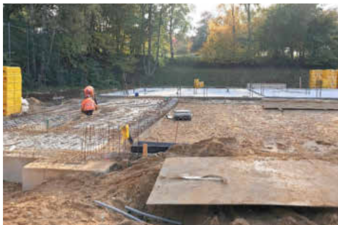
Bodenplatte: Ein Teil der Sohle ist fertiggestellt, der Rest folgt abschnittsweise.
