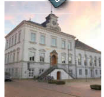
Historisches Rathaus: Der geschichtsträchtige Bau ist für das Gebäudemanagement ein spannendes Betätigungsfeld.
