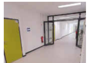
Brandschutz: Die Flure der Gemeinschaftsschule am Lehmwohld erfüllen nach der Sanierung nun strenge Sicherheitsanforderungen.
