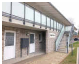
Suder Höhe: Das vom Gebäudemanagement begleitete Neubauprojekt wurde nach einem Jahr Bauzeit planmäßig im November 2019 fertiggestellt.
