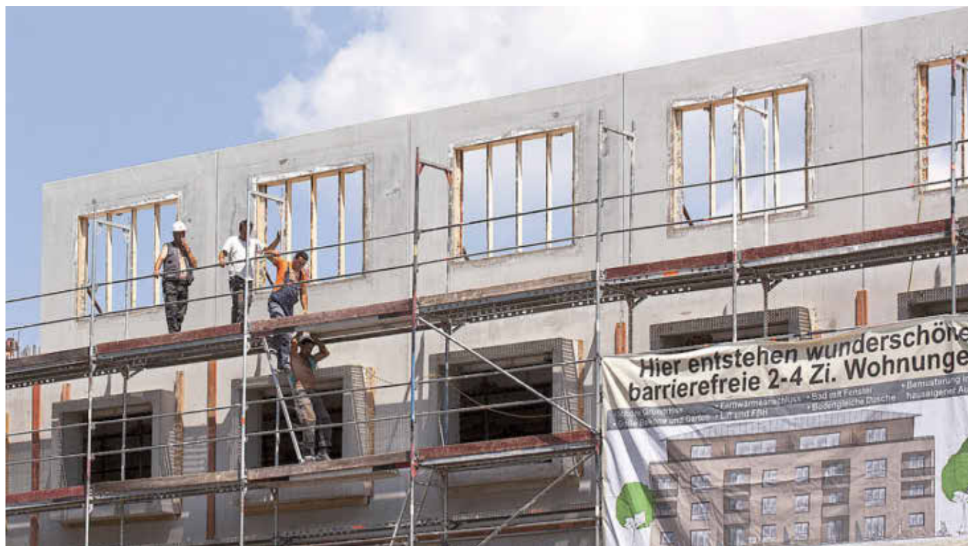
Wohnungsbau (hier ein Beispiel): Itzehoe und die Umlandgemeinden verfolgen eine gemeinschaftliche wohnbauliche Entwicklung.
