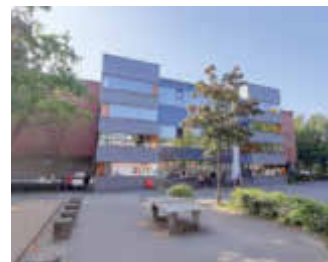
Mehr als nur Fassade: Beim Sportzentrum am Lehmwohld wurde neben den Außenwänden im Sockelgeschoss auch der gesamte Treppenaufgang energetisch saniert.
