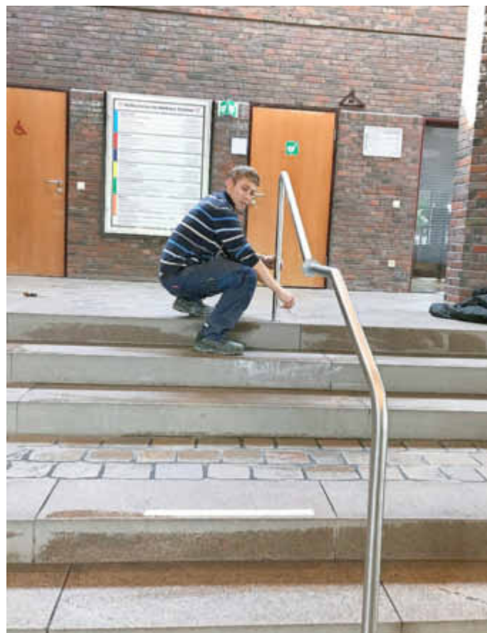
Alles im Griff: Der neue Handlauf macht das Treppensteigen sicherer.
