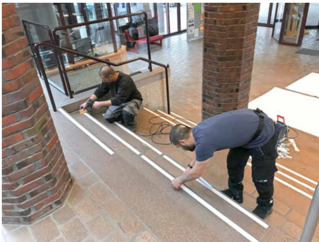
Kontrastreich: Mitarbeiter einer Fachfirma bringen die Markierungsstreifen an.
