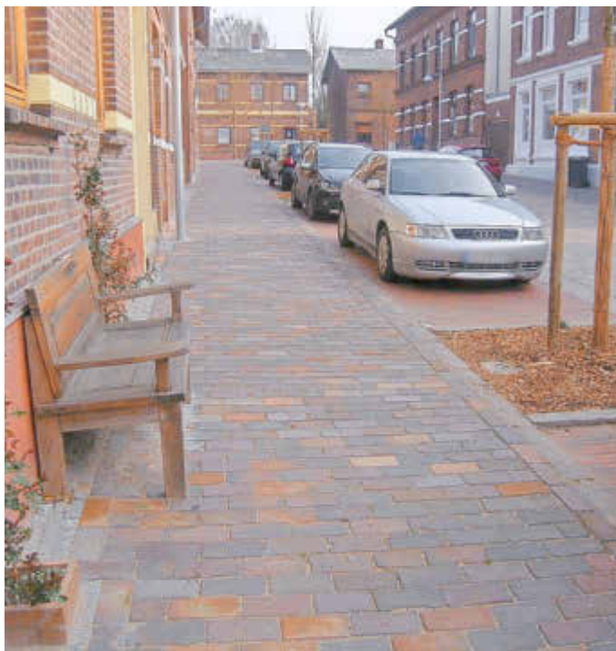
Gesamtpaket: Im Sanierungsgebiet „Östlich Hindenburgstraße“ wurden unter anderem Gehwege und Straßen erneuert.
