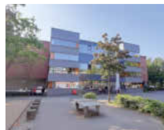
Mehr als nur Fassade: Beim Sportzentrum am Lehmwohld wurde neben den Außenwänden im Sockelgeschoss auch der gesamte Treppenaufgang energetisch saniert.
