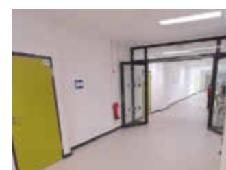
Brandschutz: Die Flure der Gemeinschaftsschule am Lehmwohld erfüllen nach der Sanierung nun strenge Sicherheitsanforderungen.
