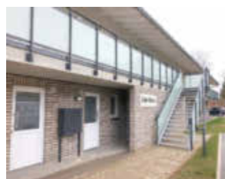
Suder Höhe: Das vom Gebäudemanagement begleitete Neubauprojekt wurde nach einem Jahr Bauzeit planmäßig im November 2019 fertiggestellt.
