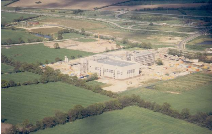
Dezember 1994: Fraunhofer ISIT vor Inbetriebnahme
