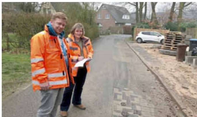
Notiert: Björn Faust und Ulrike Wallutt registrieren eine Straßenabsackung vor einem Bordstein.
